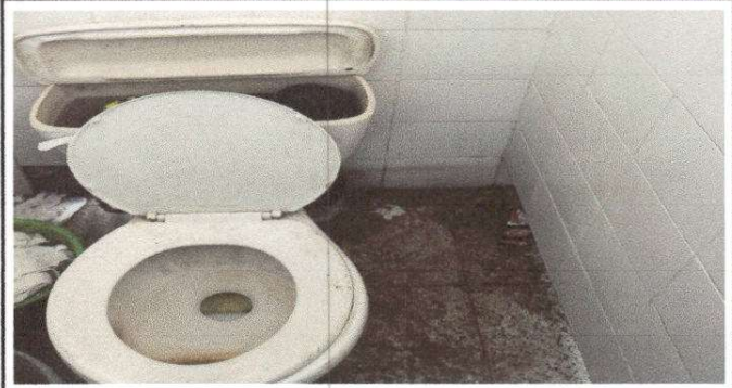
Foto 2: Sustitución de inodoro
