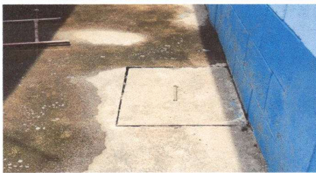
Foto 3: Mantenimiento a cajas de registro
