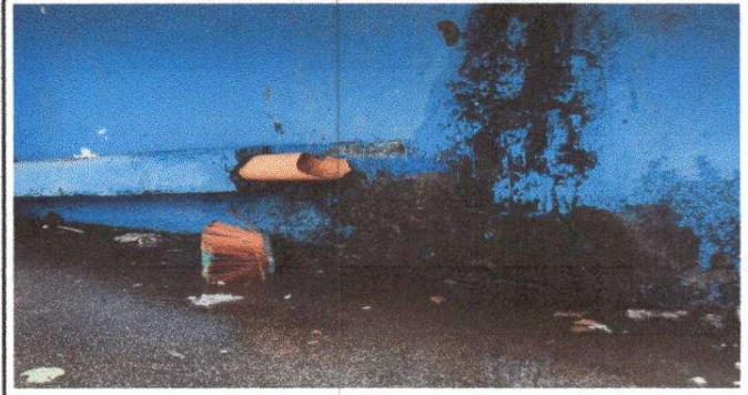
Foto 4: Sustitución de tubería PVC línea principal aguas negras (debajo del patio)
