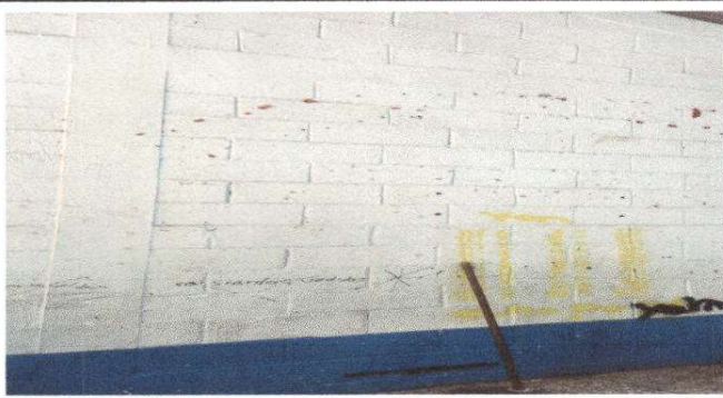
Foto 1: Pinturas en muros exteriores e interiores
