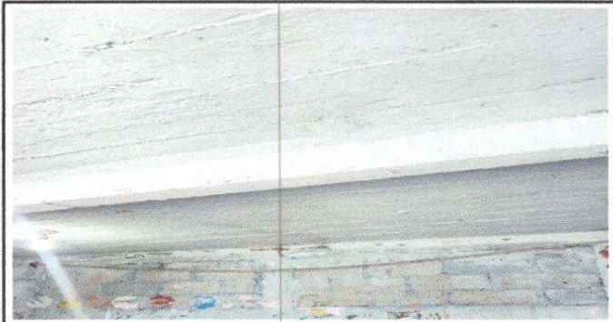
Foto 6: Repello en muro + Cernido en muro
